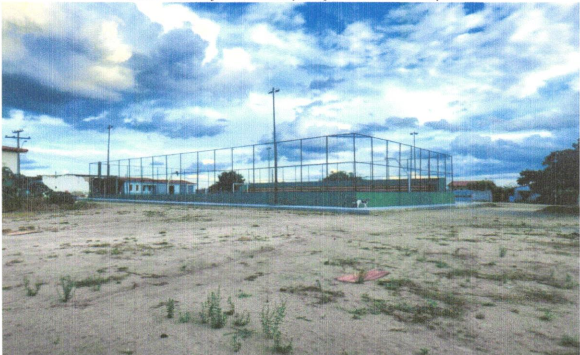
Foto 02 – Execução das luminárias.
