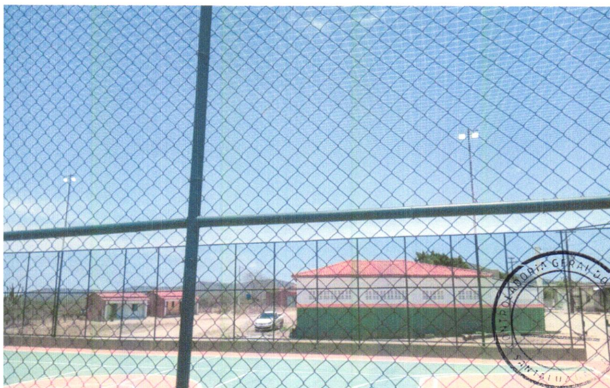
Foto 04 – Execução das luminárias.
