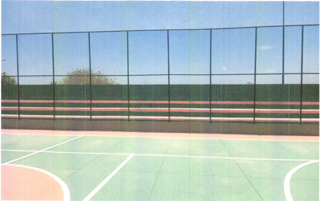
Foto 5: EXECUÇÃO DA REDE DE PROTEÇÃO
